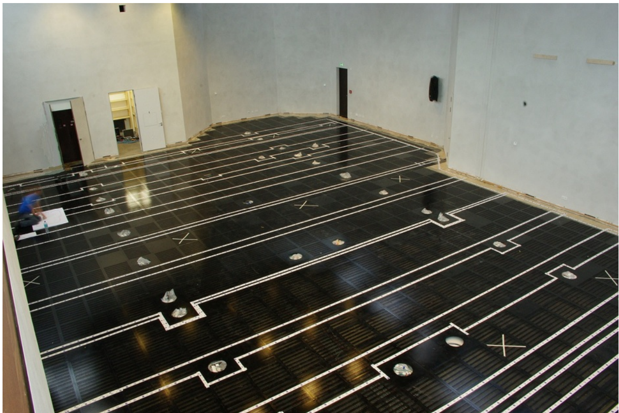
Abbildung 14 : Beispiel für die Verlegung eines Mehrsegment-Schleifensystems mit Phasen-schieber ohne Übersprechen auf einem Metallboden
