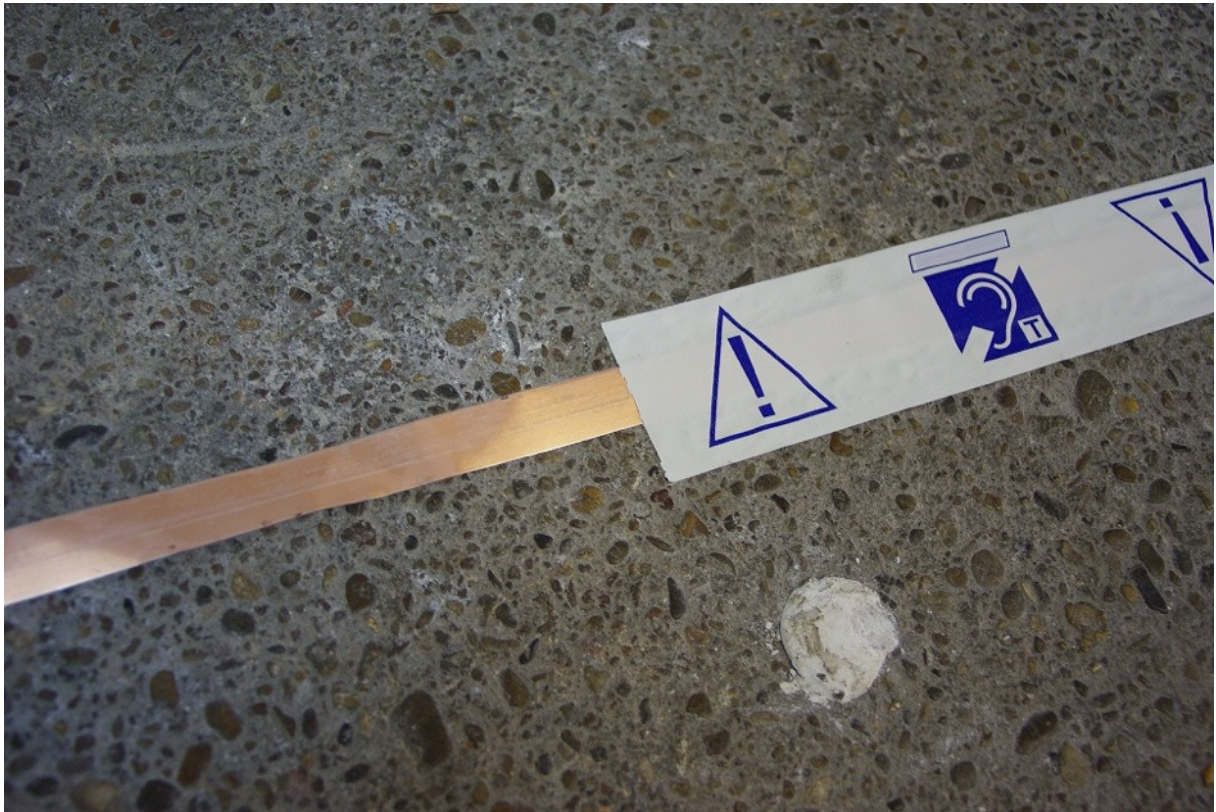
Abbildung 15 : Beispiel für die Verklebung einer Kupferschleife mittels eines Spezialklebebandes
